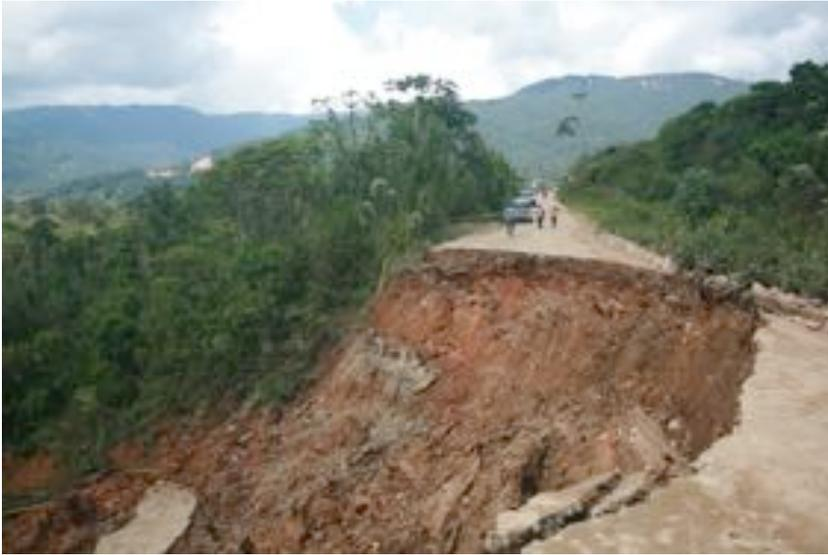
Ejemplo de deterioro de la vía comunal por el tráfico incesante de máquinas pesadas y volquetas. Foto: diario de campo.
