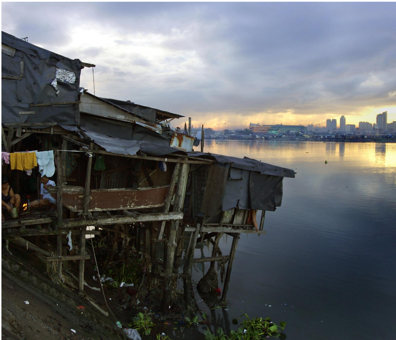
Personas en una casa construida sobre estacas junto al agua en un asentamiento informal en Manila. © Robin Hammond/Panos
